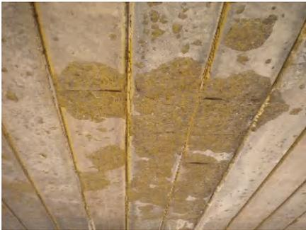
橋梁点検写真 火災(桁下面)
