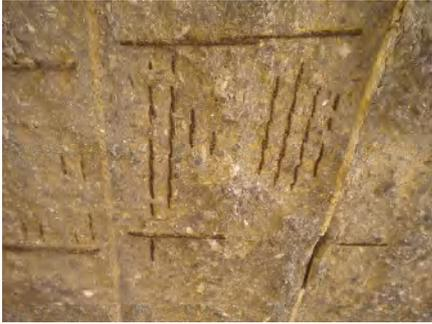
橋梁点検写真 火災(PC鋼線露出)
