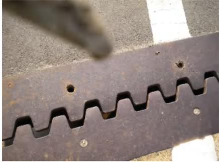
橋梁点検写真 継手の土砂堆積
