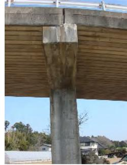
橋梁点検写真 橋脚の傾きと回転
