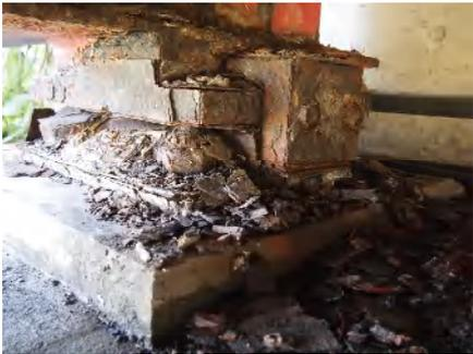
橋梁点検写真 支承の腐食
