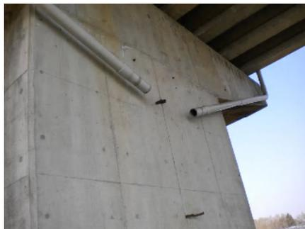
橋梁点検写真 パイプ支持金具の防錆
