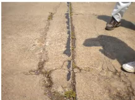
橋梁点検写真 舗装の割れ
