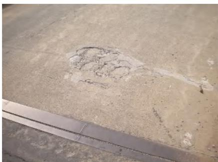
橋梁点検写真 舗装の割れ
