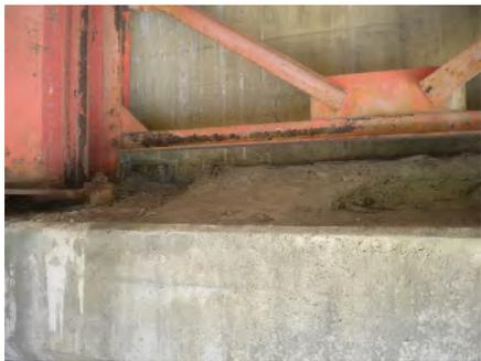
橋梁点検写真 沓座面の土砂堆積
