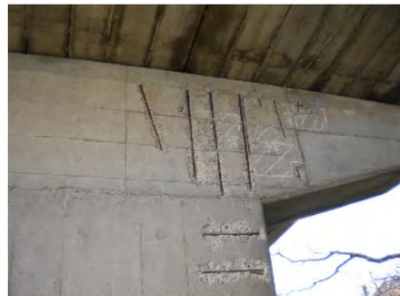
橋梁点検写真 橋脚(剥離と鉄筋露出)
