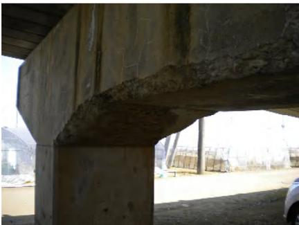
橋梁点検写真 火災(橋脚)
