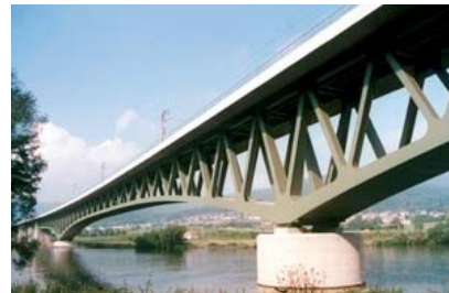
レオンハルトの設計 2重合成桁 高速鉄道橋
